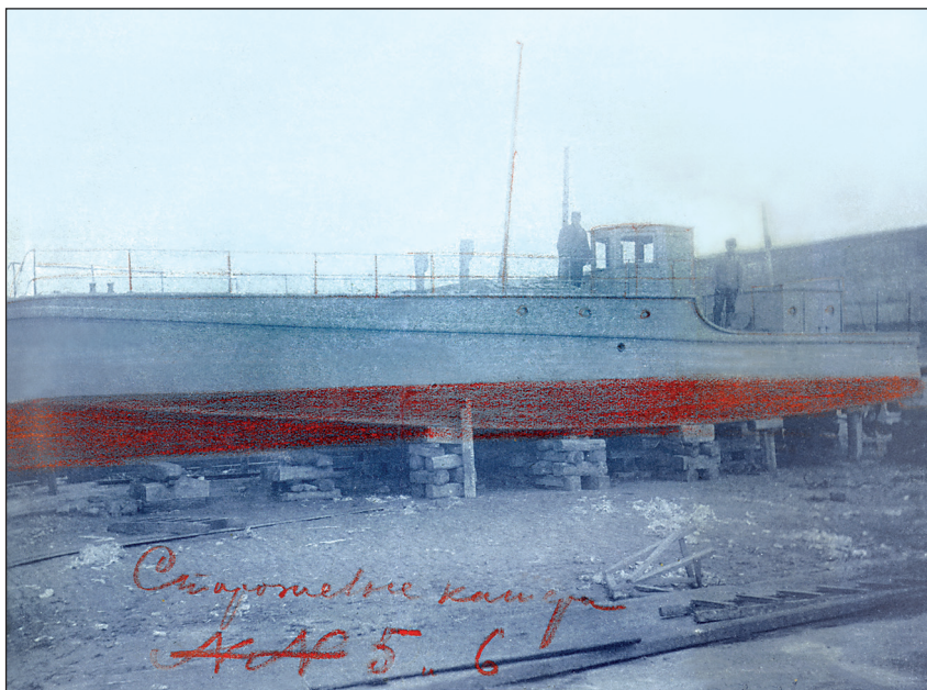
Переоборудование катера 1-й серии для нужд Службы связи. Завод К. О. Ревенского, 1917 г. РГА ВМФ, ф. 610, оп. 1, д. 236, л. 45
