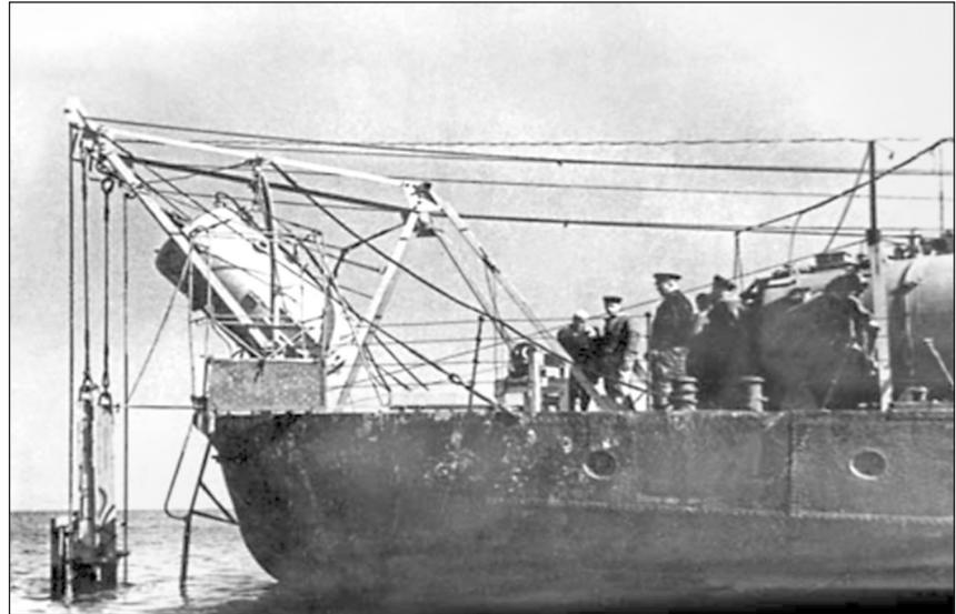
Рис. 3 Подъем водолазного колокола на спасательном судне, переоборудованном из немецкого тральщика серии «М»
